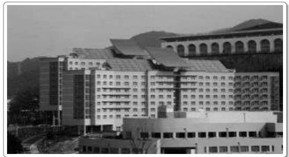
< 설치사례 : 조선대 기숙사 태양광시설 53kWp >
